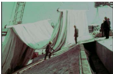
ファブリックを貼る作業
