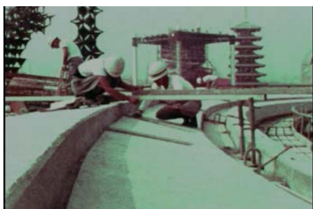
高い水準での施工精度が求められ、リング（外周部）の施工に際しては施工前・中・後と度重なる測量が行われた
