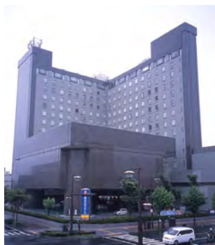
村野藤吾〈宇部興産ビル〉1983年、山口県宇部市〔撮影：松隈洋〕
