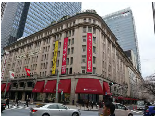
高橋貞太郎、村野藤吾（増築部分）〈日本橋高島屋（旧東京日本生命館）〉1933年・1951-1965年（増築部分）、東京都中央区
