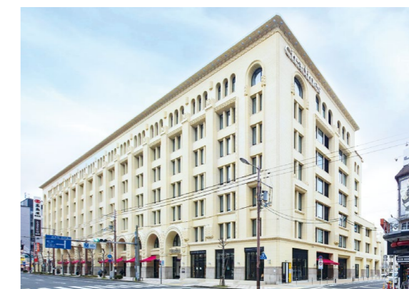
上:日本橋高島屋本館(東京) 下:高島屋東別館(大阪)
