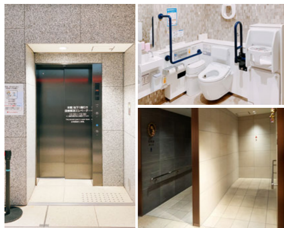
左：段差解消エレベーター 右上：車いすで利用できる多機能トイレ 右下：改修によりスロープ化した日本橋高島屋S.C.本館B1化粧室
