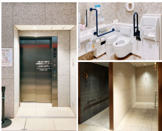
左：段差解消エレベーター 右上：車いすで利用できる多機能トイレ 右下：改修によりスロープ化した日本橋高島屋S.C.本館B1化粧室
